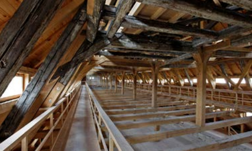
Zwickau, Niederes Kornhaus, Dachstuhl
